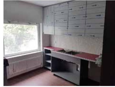
Blick in die Teeküche
